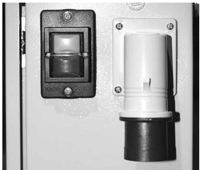
Fiche d'alimentation CEE 3 pôles 230 V / 16 A (à droite) sur l'armoire de distribution
