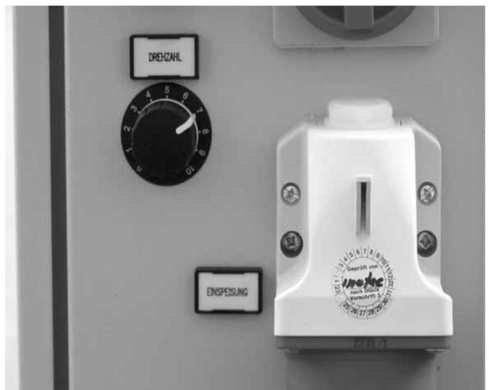
5-poliger 400 V / 25 A CEE-Einspeisestecker (rechts) am Schaltschrank unterhalb des Hauptschalters.
