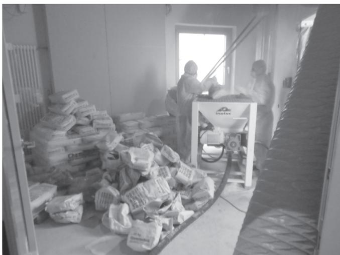
Materialbestückung des Kleinsilos mit Sackware (hohe Staubentwicklung); Raumhöhe mind. 180 cm.
