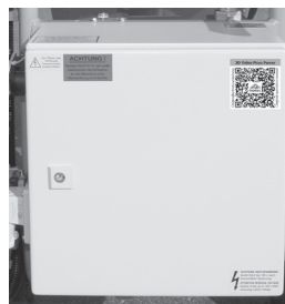
Hinweise auf dem Schaltschrank vorne
