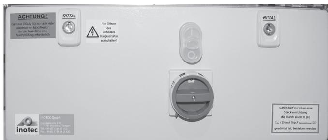
Schaltschrank mit Hauptschalter: Handbetätigbarer roter Drehschalter mit nur einer Aus- und einer Ein-Stellung, die eindeutig mit 0 und 1 gekennzeichnet ist. Der darüberliegende Drucktaster schaltet den Mischer ein (I) und aus (O).
