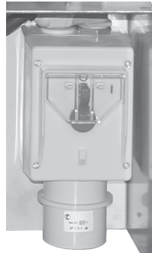
Stromanschluss am Hauptschalter (400 V / 16 A)
