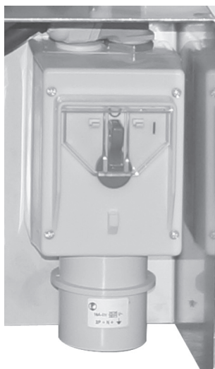
Stromanschluss am Hauptschalter (400 V / 16 A)
