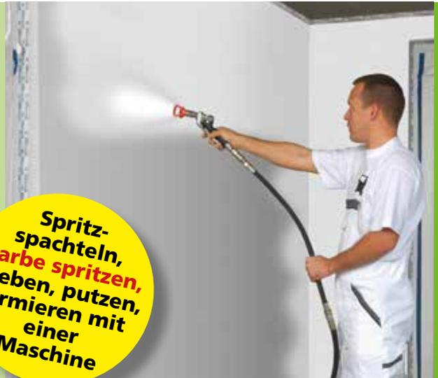
Die **inoBEAM F30** ist eine leistungsfähige 230 V Förderpumpe, die für vielseitige Anwendungen im Innen- und Außenbereich einsetzbar ist. Mit einem optional erhältlichen Bausatz kann die Förderpumpe mit ein paar Handgriffen für verschiedene Anwendungsbereiche umgerüstet werden. **So wird mit dem Bausatz „HP“ aus der Förderpumpe eine leistungsstarke Hochdruckpumpe für Airless-Spritzspachtelmassen.**
