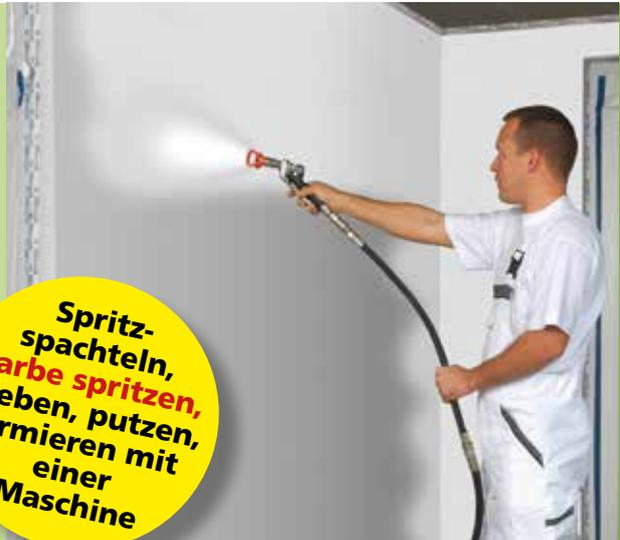
Die **inoBEAM F40** ist eine leistungsfähige 400 V Förderpumpe, die für vielseitige Anwendungen im Innen- und Außenbereich einsetzbar ist. Mit einem optional erhältlichen Bausatz kann die Förderpumpe mit ein paar Handgriffen für verschiedene Anwendungsbereiche umgerüstet werden. **So wird mit dem Bausatz „HP“ aus der Förderpumpe eine leistungsstarke Hochdruckpumpe für Airless-Spritzspachtelmassen.**
