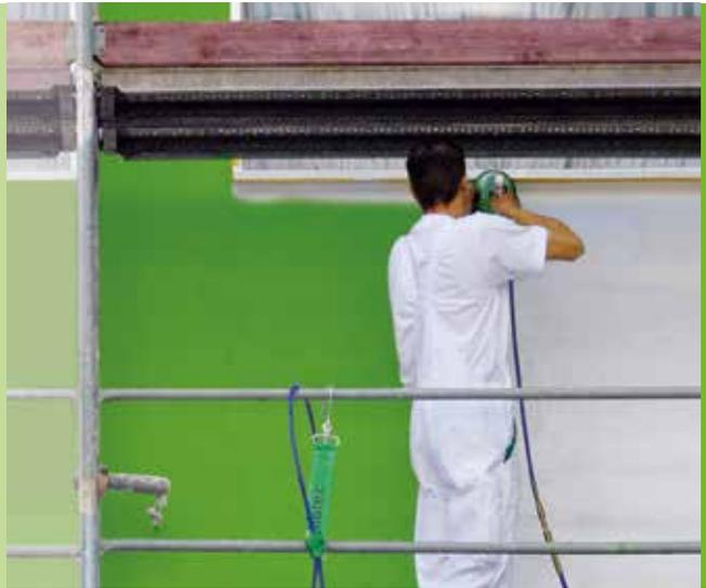
Die **inoSPRAY MP5** ist ein kompaktes 230 V Airless-Spritzgerät für den effizienten Einsatz an Fassaden und in Innenräumen. Dank hoher Förderleistung können auch größere Objekte oder Flächen in kurzer Zeit beschichtet werden.
