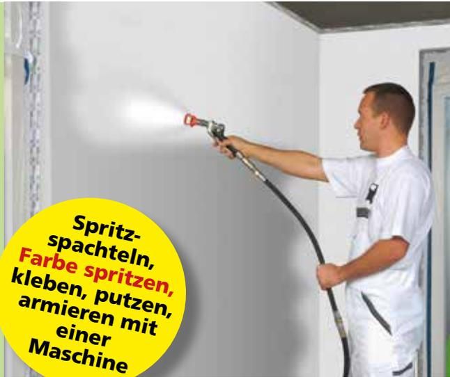
Die **inoBEAM F12** ist eine kompakte, leichte und vielseitig einsetzbare 230 V Förderpumpe. Mit einem optional erhältlichen Bausatz kann die Förderpumpe mit ein paar Handgriffen für verschiedene Anwendungsbereiche umgerüstet werden. **So wird mit dem Bausatz „HP“ aus der Förderpumpe eine leistungsstarke Hochdruckpumpe für Airless-Spritzspachtelmassen.**
