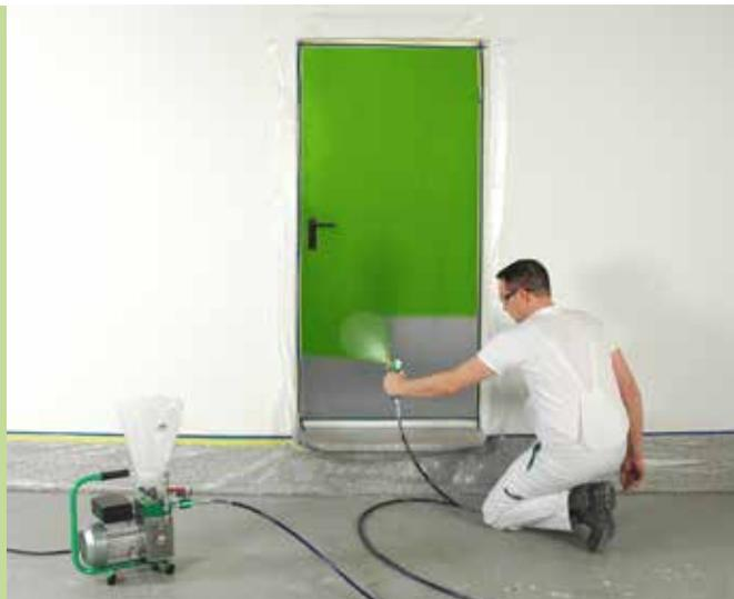
El **inoSPRAY A 4000** es un dispositivo airless de membrana de aplicación universal para pulverizar dispersiones en superficies pequeñas, para pintar y prensar.
