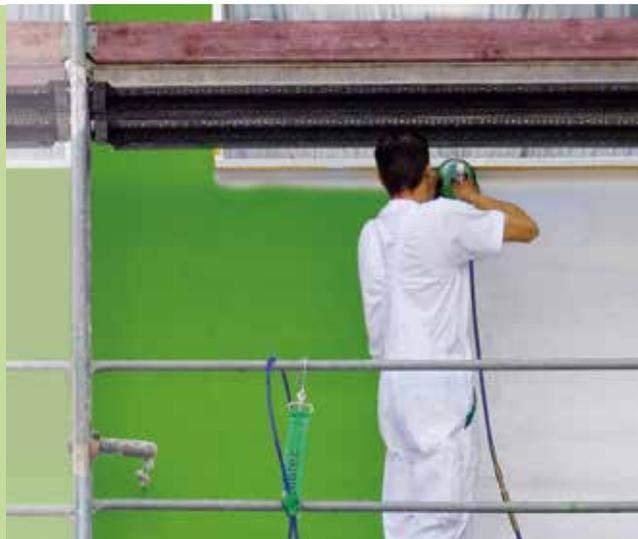
El **inoSPRAY M5** es un pulverizador compacto airless de 230 V para un uso eficiente en fachadas e interiores. Gracias a su alta capacidad de bombeo, se pueden cubrir inmuebles o superficies de gran tamaño en poco tiempo.
