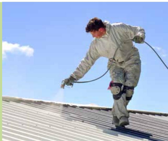
El **inoSPRAY M3** es un pulverizador compacto airless de 230 V para un uso eficiente en fachadas e interiores. Gracias a su alta capacidad de bombeo, podrán cubrirse inmuebles o superficies de tamaño medio en poco tiempo.
