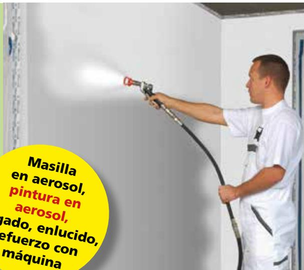
La **inoBEAM F70** es la bomba de 400 V de gran potencia que puede utilizarse para una amplia gama de aplicaciones en interiores y en exteriores. Con un kit opcional disponible, la bomba de alimentación se puede adaptar a distintos ámbitos de aplicación en unos pocos pasos. **El kit «HP» convierte la bomba de alimentación en una potente bomba de alta presión para masillas en aerosol airless.**
