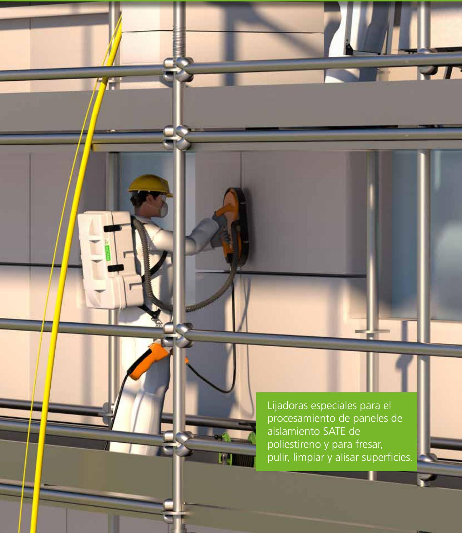
Lijadoras especiales para el procesamiento de paneles de aislamiento SATE de poliestireno y para fresar, pulir, limpiar y alisar superficies.
