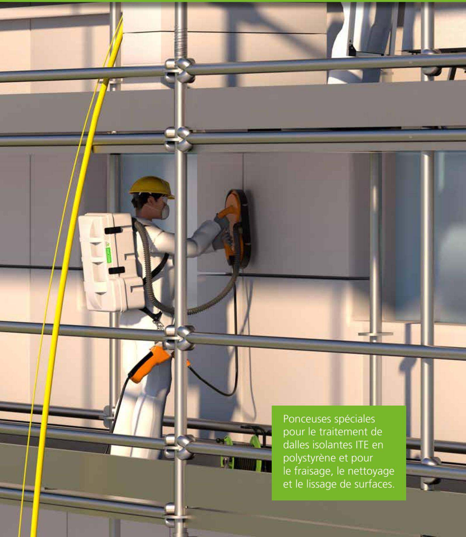
Ponceuses spéciales pour le traitement de dalles isolantes ITE en polystyrène et pour le fraisage, le nettoyage et le lissage de surfaces.
