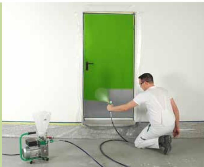
L' **inoSPRAY A 4000** est un appareil Airless à membrane universel pour la pulvérisation de dispersions sur des petites surfaces, pour les travaux de vernissage et de pressage.
