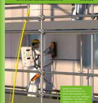
Spezial-Schleifgeräte für die Bearbeitung von WDWs-Dampfsperren aus Polypropylen und zum Abstrich, Ratschieren, Putzen und Glätten von Oberflächen.
