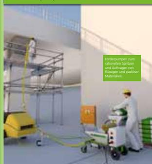
Förderpumpen zum rationellen Spitzen und Auftragen von flüssigen und pastösen Materialien.
