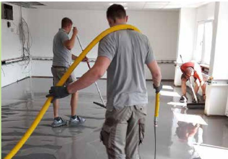
L'**inoBEAM F70** est la pompe d'alimentation performante de 400 V, utilisable pour diverses applications en intérieur et en extérieur. Particulièrement adaptée aux enduits d'assainissement, enduits structurés monocouches, matériaux de réparation du béton et masses d'égalisation des sols ou mortier de reprofilage.
