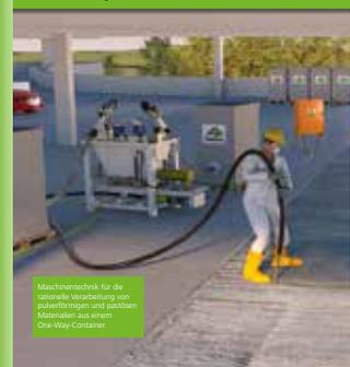
Maschentechnik für die rationale Verarbeitung von pulverförmigen und pastösen Materialien aus einem One-Way-Container.
