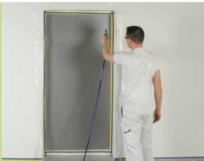
Le modèle **inoSPRAY M2** est un pulvérisateur Airless universel de 230 V pour la pulvérisation de dispersions sur des petites surfaces avec buses jusqu'à 0,021".
