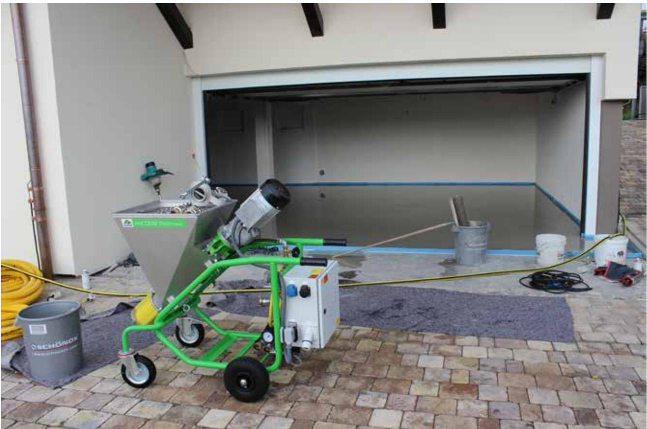
Nach nur einer Stunde sind 50 Materialsäcke Ausgleichsmörtel in gleichbleibender Qualität auf den 75 qm verteilt.
