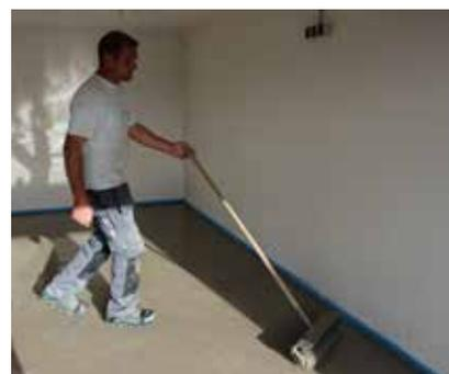
Mit der Entlüftungswalze wird das Material entlüftet.
