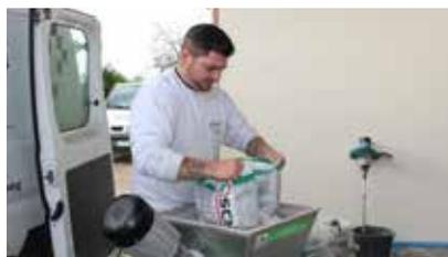
Das Material muss nicht mehr mit dem Handrührgerät gemischt werden. Einfach nur die Sackware in den Behälter der Mischpumpe füllen.
