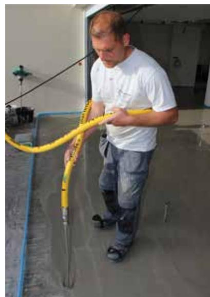
Das Material wird aufgetragen und Nivellierböcke geben die exakte Ausgleichshöhe an.
